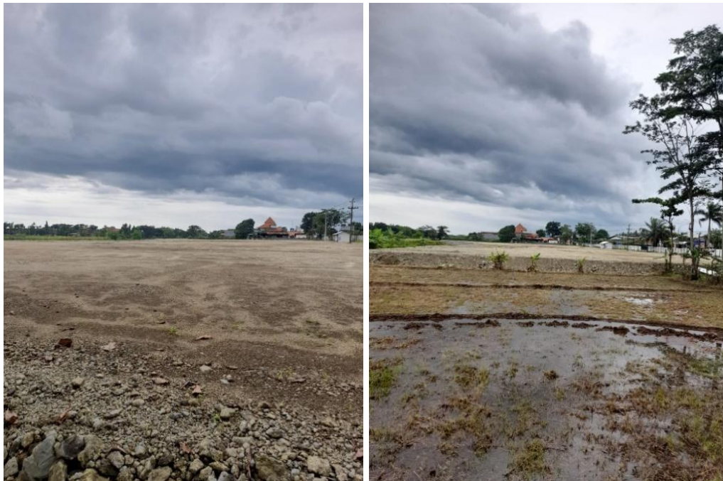
Gambar 38. Progres Pembangunan Terminal Tipe A hingga Akhir Tahun 2022
