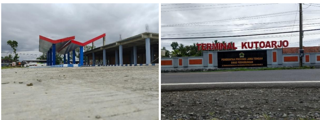
Gambar 39. Progres Pembangunan Terminal Tipe B hingga Akhir Tahun 2022
