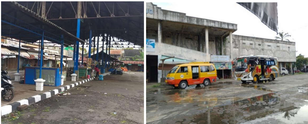
Gambar 40. Kondisi Eksisting Terminal Tipe C Kongsis (kiri) dan Terminal Tipe C Kutoarjo (kanan)
